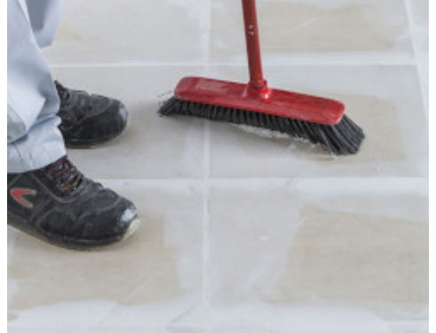
Entfernen von Staub nach dem Schleifgang
