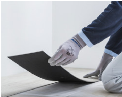
Verlegung von selbstklebendem PVC-Designbelag auf mit Planiprep 4 LVT gespachtelten keramischen Fliesen
