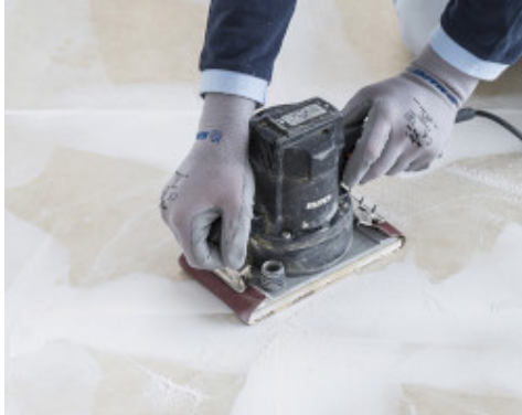
Schleifen des mit Planiprep 4 LVT gespachtelten Untergrundes
