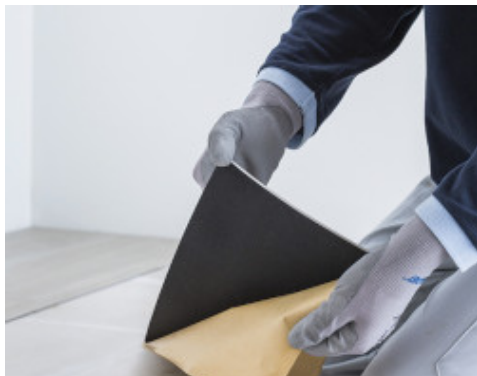
Entfernen der Schutzfolie von der Rückseite eines selbstklebenden PVC-Designbelages
