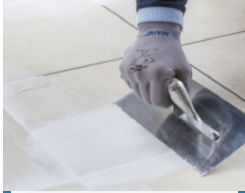
Spachteln und Verschließen von Fugen in einem bestehenden Fliesenbelag mit Planiprep 4 LVT
