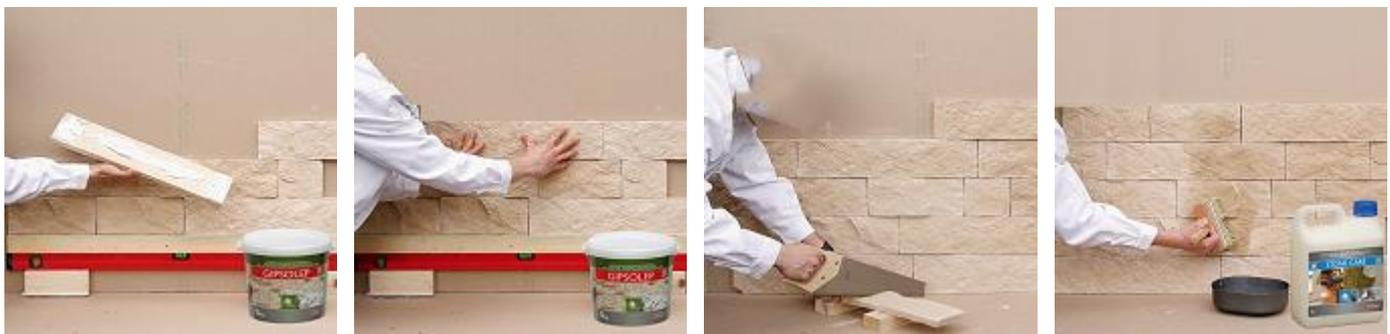
Um die Steinriemchen zu bearbeiten, benutzen Sie bitte einen Nass-Fliesenschneider oder einen Winkelschleifer / Trennschleifer mit einer Steintrennscheibe. Nach dem Schneiden sind die Schnittstellen der Steinriemchen mit klarem Wasser zu reinigen.
