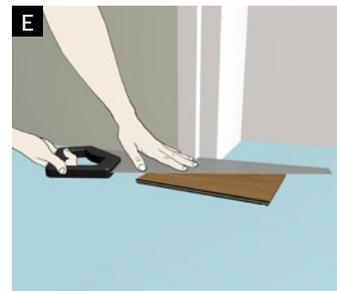
**E.** Wenn Sie eine Türzarge kürzen müssen, verwenden Sie eine Diele als Anschlag, so erhalten Sie die exakt richtige Höhe. Wenn Sie eine Diele an der langen Seite klopfen müssen, schützen Sie die Dielenverriegelung mit einem Reststück das sie in die Verbindung einklicken.
